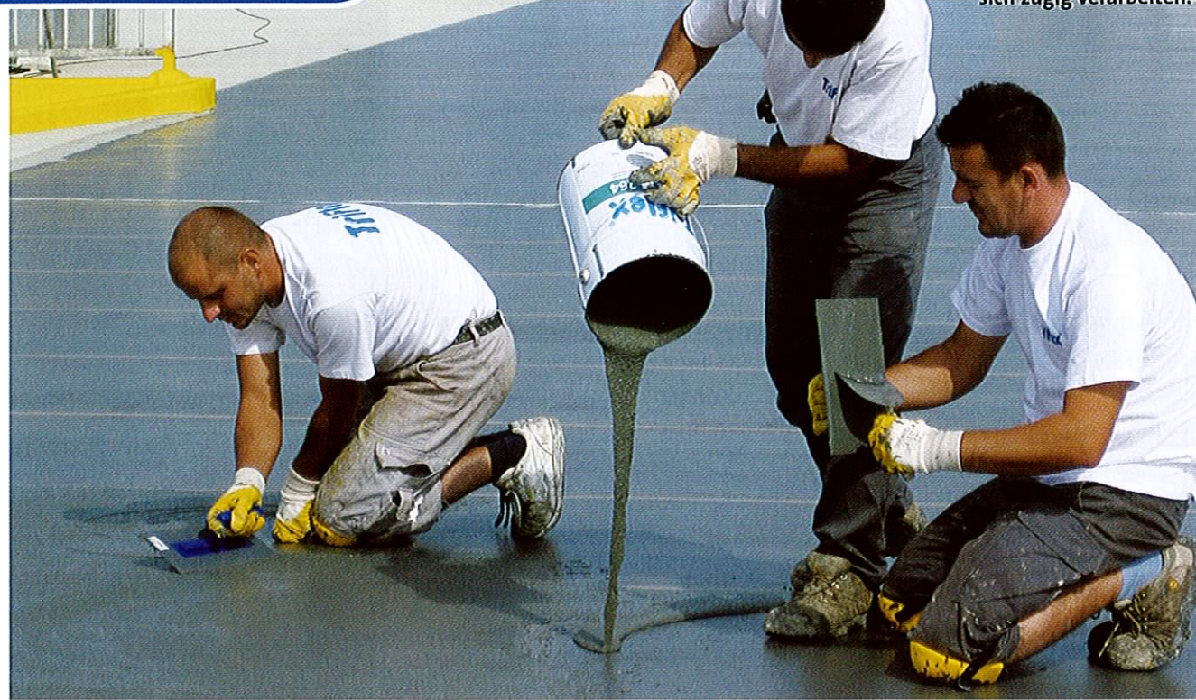
Innovativer Baustoff: Flüssigkunststoffe lassen sich zügig verarbeiten.
