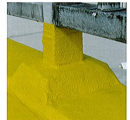
Verschiedene Stadien einer Sanierungsmaßnahme
